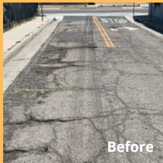
Hot Patch repair on Union between N. E St. & N. F St.
