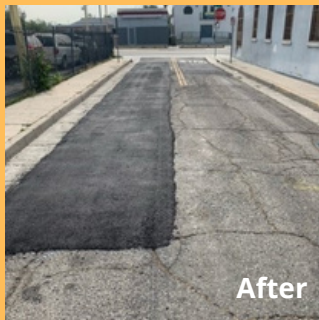
Hot Patch repair on Union between N. E St. & N. F St.
